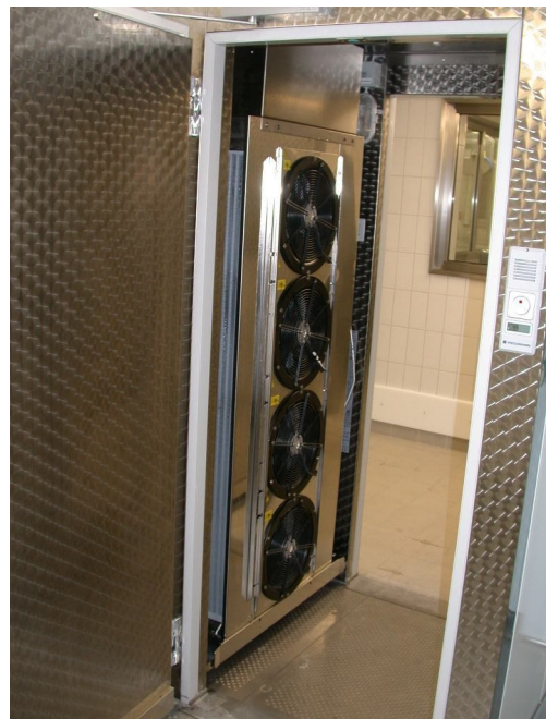
Tiefkühlzelle mit eingebautem Verdampfersystem zur Nutzung als Schnellkühler für Hordenwagen GN 2/1
