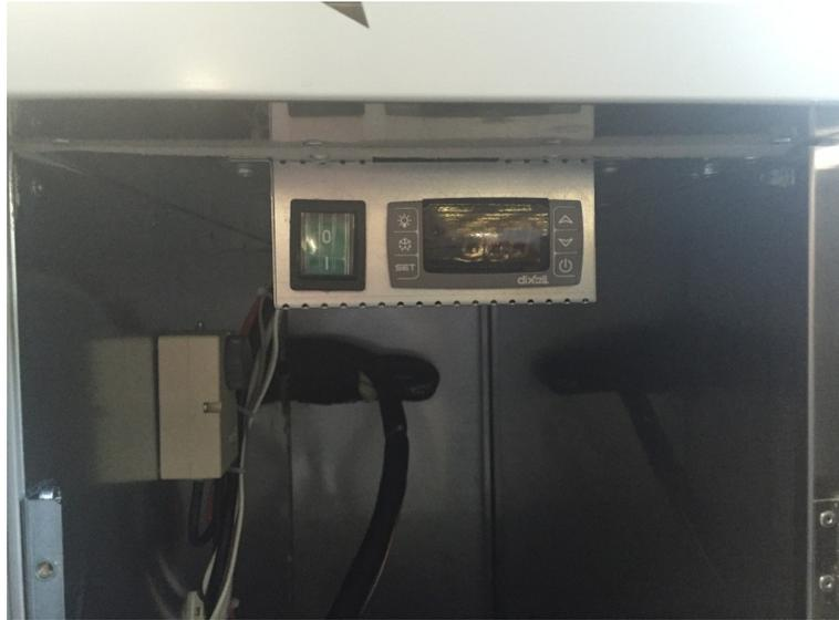
Die Maschinenfachblende hat vorne vorgestanzte Ausschnitte für den Hauptschalter und die Elektronik. Wenn der Zugang zur Elektronik permanent erfolgen soll, so kann die Elektronik mit dem Hauptschalter nach vorne in die Frontblende versetzt werden. Hierfür die Sollbruchstellen nutzen und die Elektronik und den Hauptschalter dort einsetzen.
